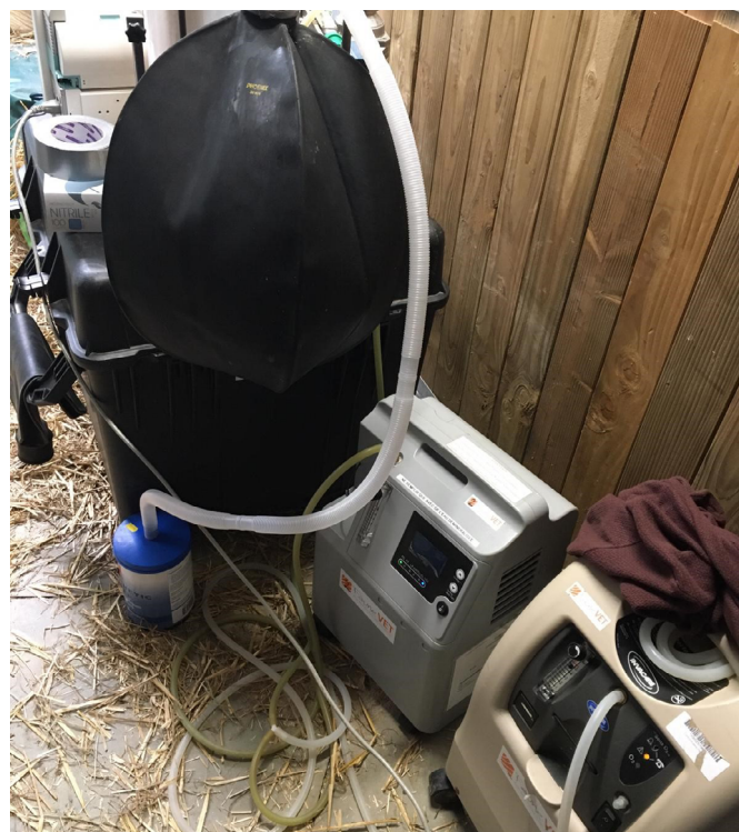
Photo 3 - Condensateurs à oxygène : deux boîtiers branchés en série, Ballon réservoir de 30L et Circuit de vidange : poubelle au sol © FauneVET
